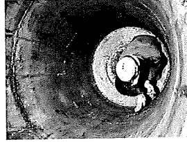
ภาพที่ 11 ข้อมแรมผนัง coil cement ด้วย Super3000
